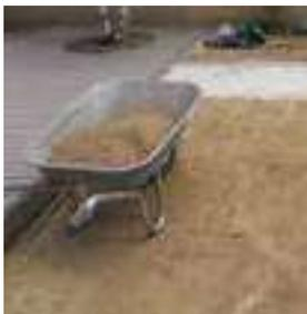
**Respectez 3 principes : support drainant / stabilisé / nivelé**
